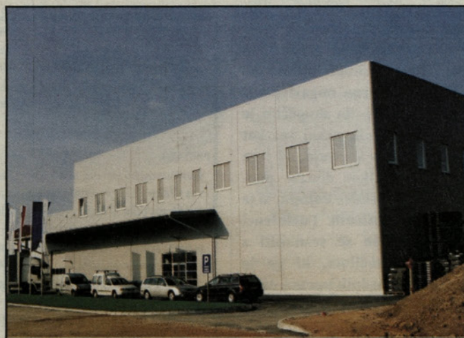
Nova proizvodna hala, ki meri kar 7.600 kvadratnih metrov površine
