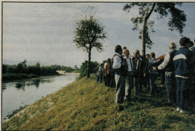
Nabrežje v dolžini 660 m
