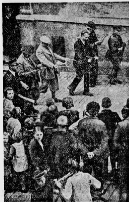
Z bajanico hočejo razložiti, odkod razpoke v zidu!
