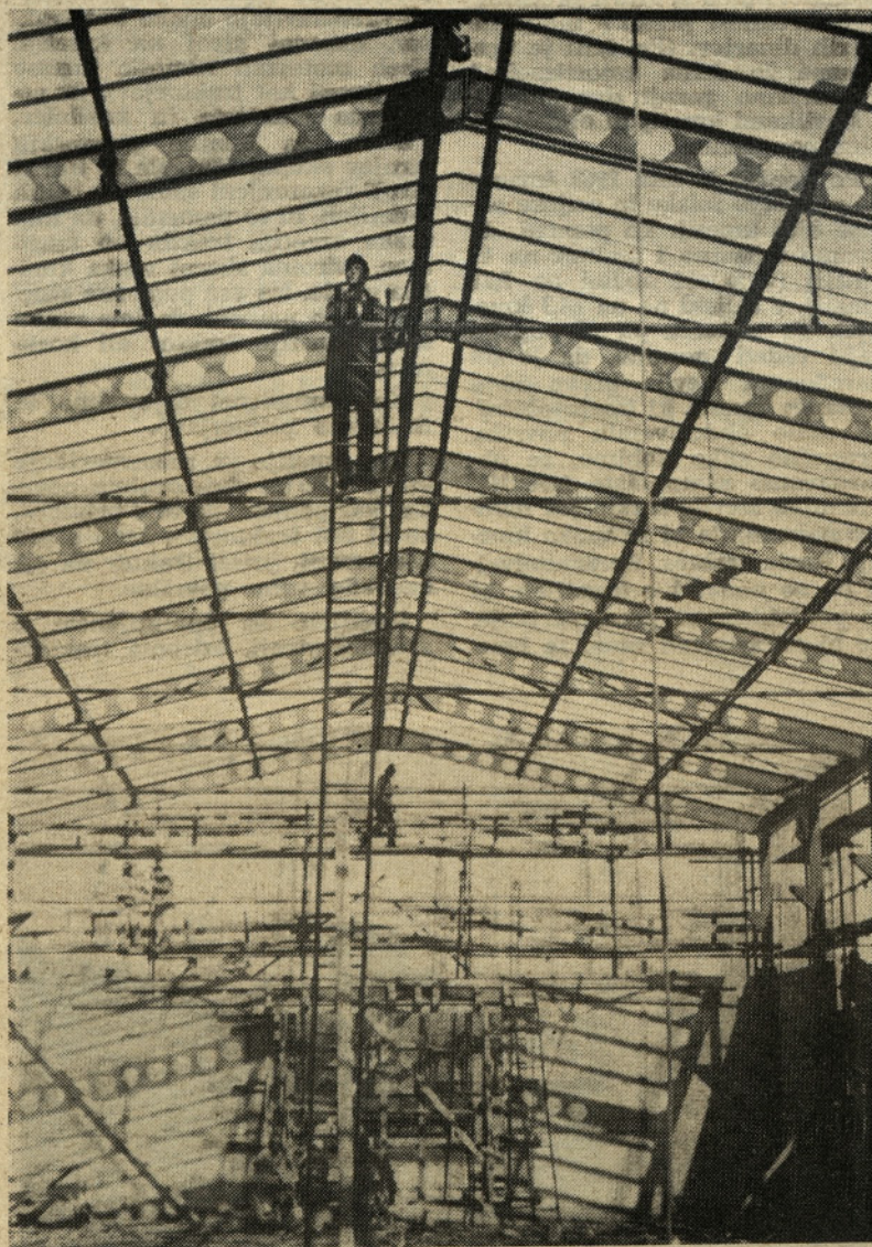
Gradnja nove hale nasproti železniške postaje v Žalcu je v polnem teku. V njej bo kolektiv SP razvil proizvodnjo obiralnih strojev za hmelj in drugih kmetijskih strojev. Ugodno vreme bo omogočilo, da bo proizvodnja stekla v predvidenem roku
