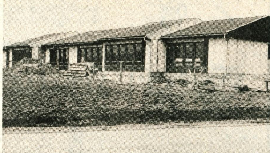
Vrtec v Mostah — Lani so v Mostah pri Komendi začeli graditi nov otroški vrtec, ki bo sprejel sto varovancev. Investitor je skupnost otroškega varstva Kamnik, ki ga bo dala v upravljanje osnovni šoli. Odprt bo v začetku naslednjega šolskega leta. (H. J.) — Foto: F. Perdan
