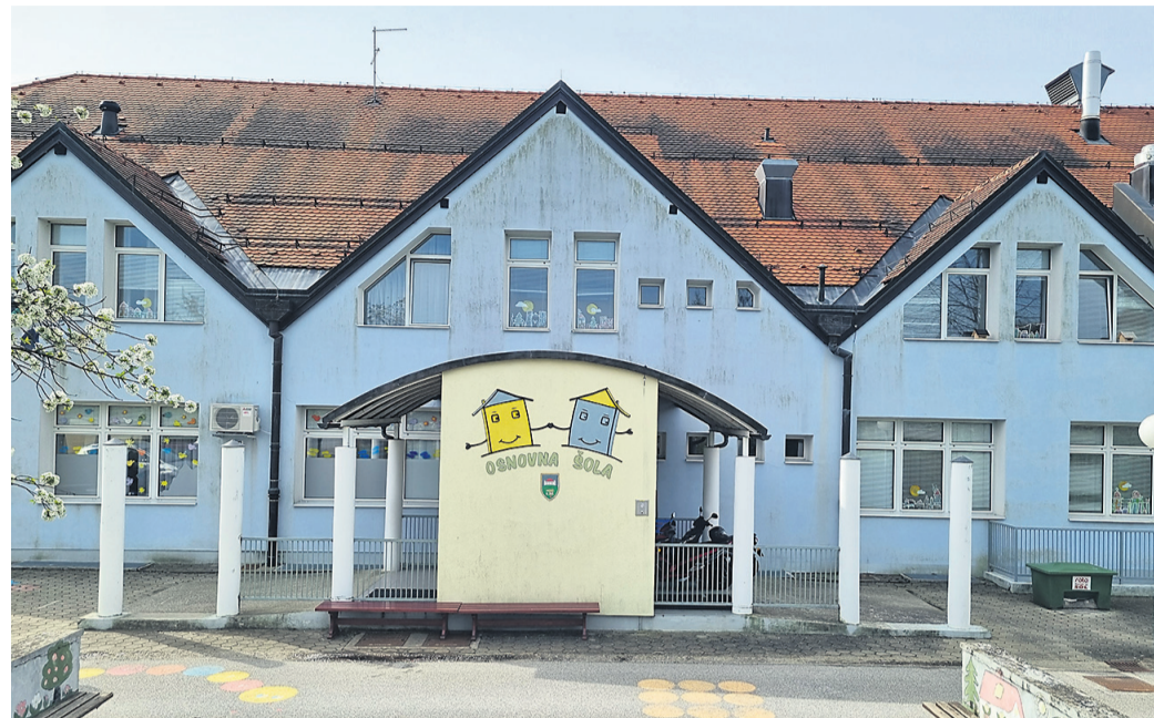
Na streho šolske stavbe v Zavrču namestitev sončne elektrarne ni možna, saj stoji na varovanem območju kulturne dediščine – v bližini so dve cerkvi in pokopališče.
