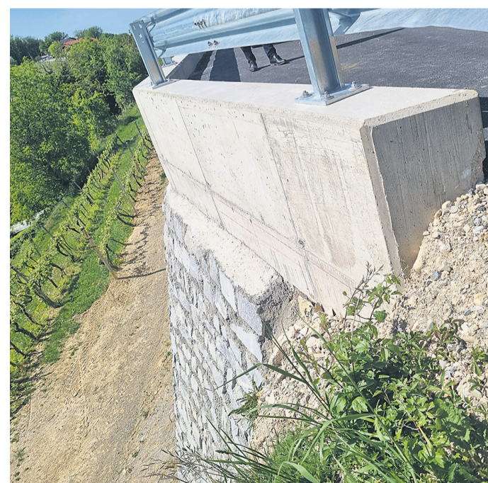
Zaključena sanacija plazov na lokalni cesti Hrastovec, ki vodi proti turističnim znamenitostma Švabovo in Vrbanjšek.
