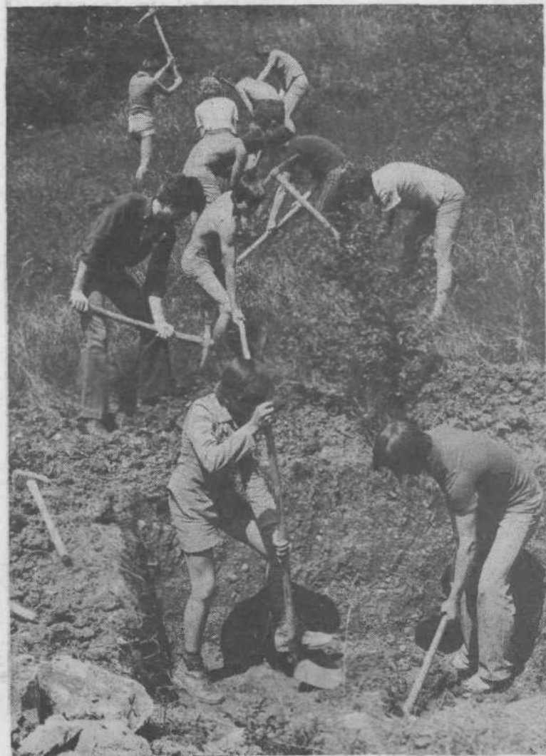
Na trasi bodočega vodovoda
