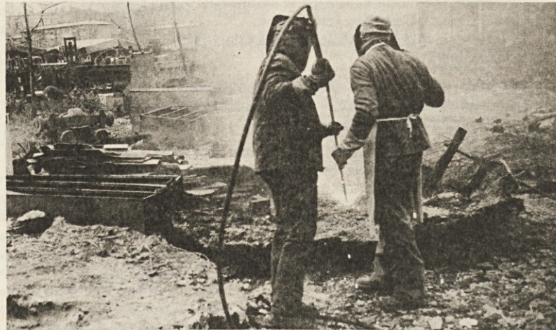
Rezanje jeklarske svinje — mešanice žlindre in visokolegiranega jekla (Foto: t.š.)
