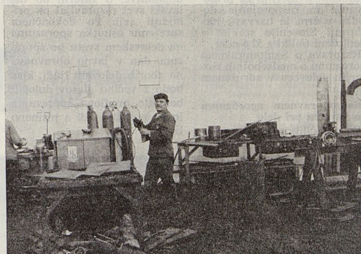
Iz strojne delavnice
