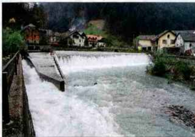
Večjo poplavno varnost bi v Železnikih zagotovili z znižanjem Dermotovega jezusa.
