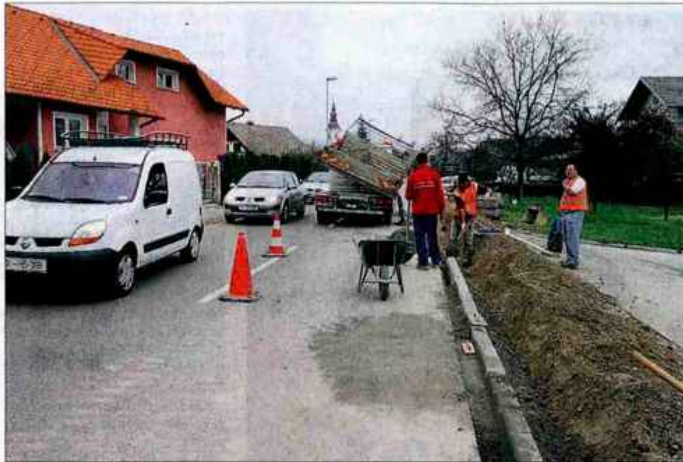
Gradnja pločnika na Visokem ovira promet, bo pa zato že kmalu varnejši za pešce. Foto: Tina Dokl
