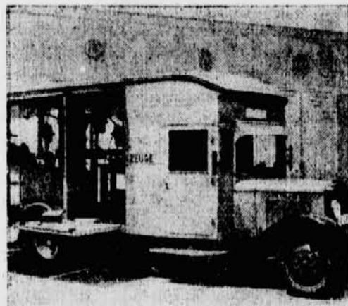
Der neue Werkstattwagen in Stahlausführung zur Autoreparatur auf der Landstraße.
