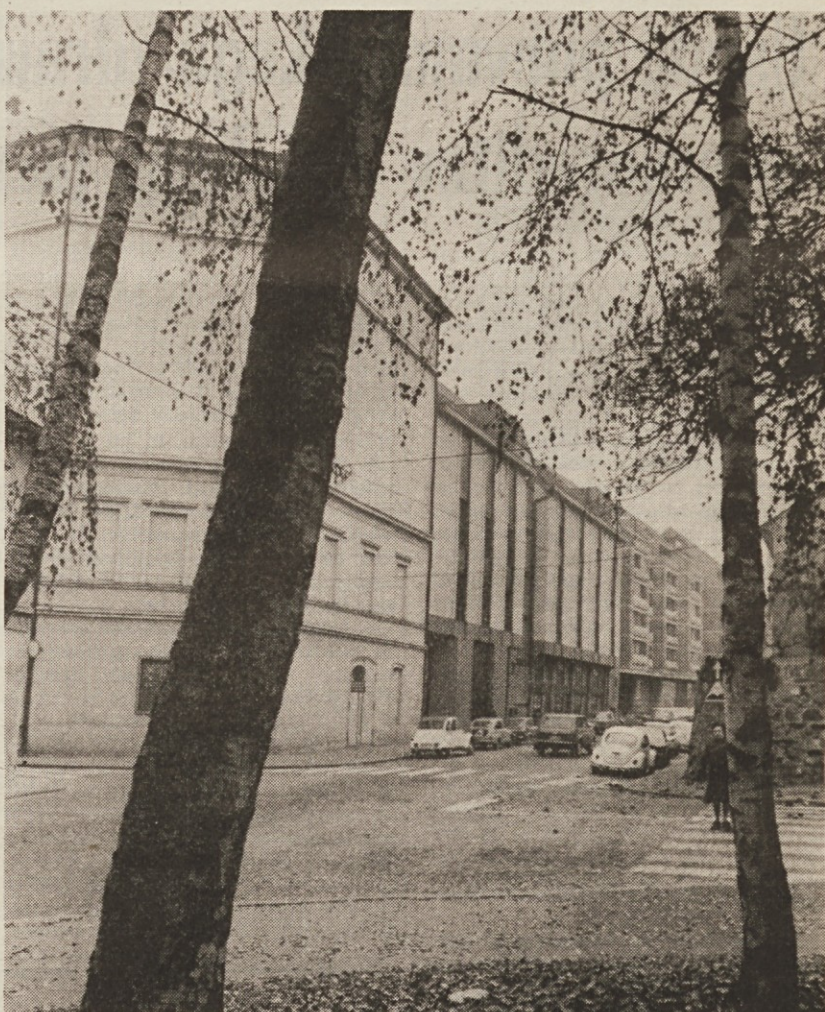
V Mariboru se nadaljujejo obnovitvena dela Drame SNG. Staro poslopje bo tako dobilo novo podobo. Gradnjo so že končali na zadnji strani, kjer je oder, medtem ko bo treba na nov videz vhoda na Slomškovem trgu še počakati
