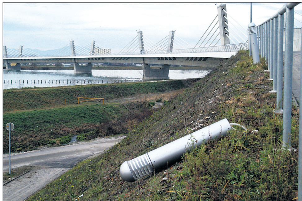
Pogled na uničene in polomljene obcestne svetilke na Puhovem mostu.
