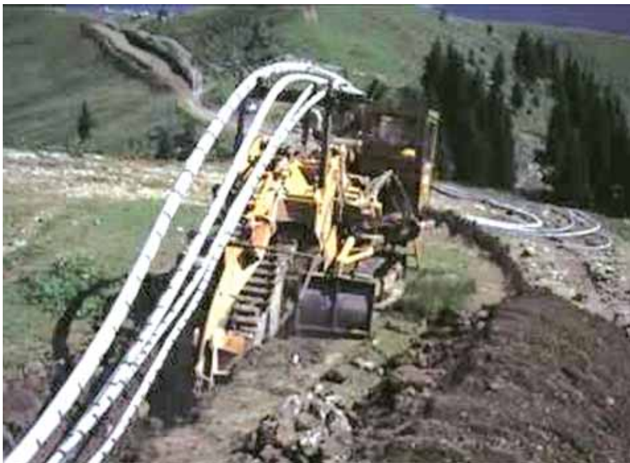
Slika 7 • Izkop in polaganje cevi direktnega odvajanja odpadnih vod s frezo
