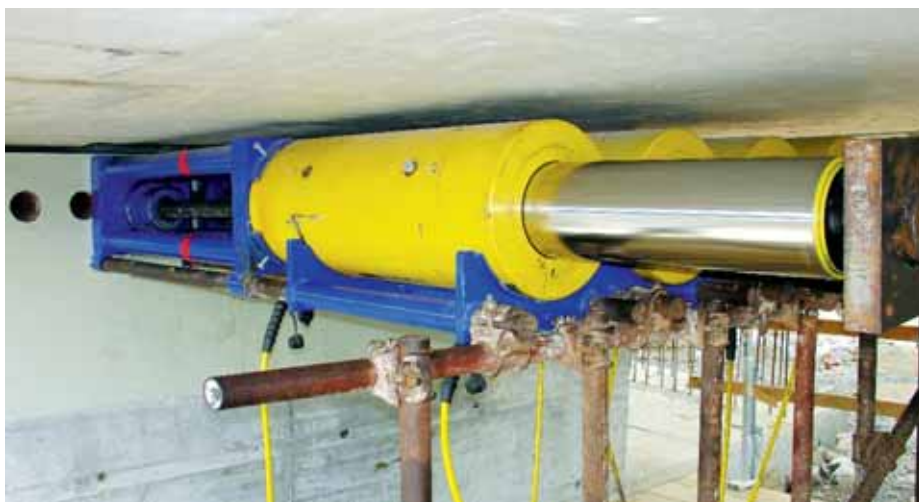
Slika 2 • Sistem vlečenja in zadrževanja s palicami Dywidag
