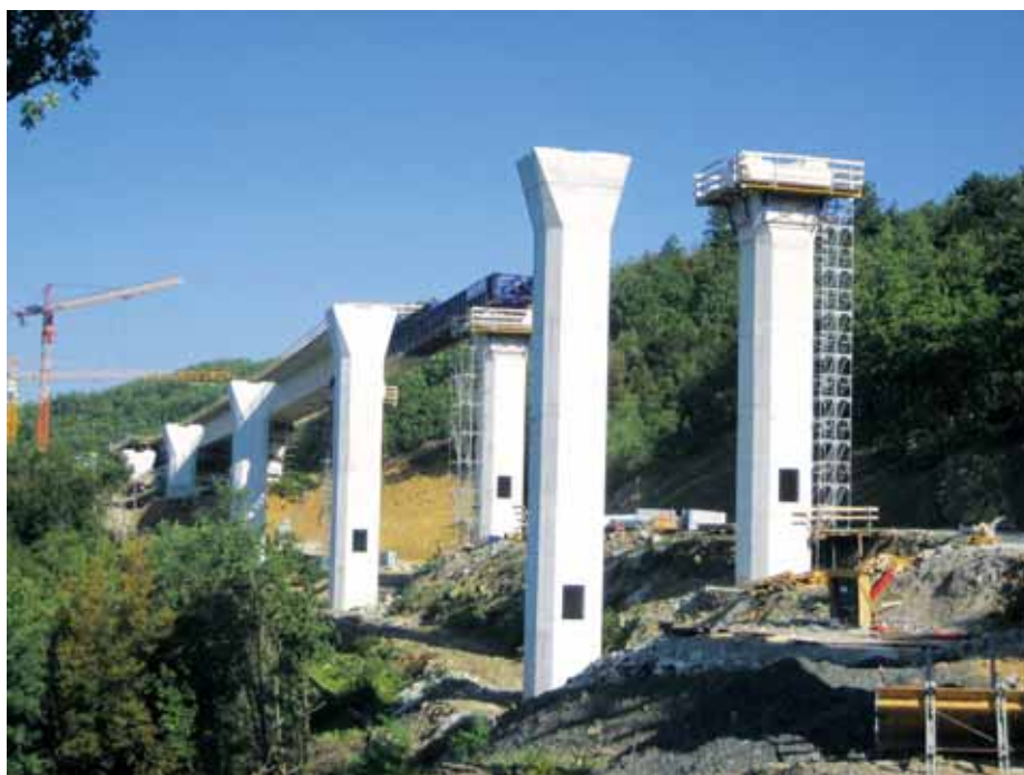
Slika 4 • Severozahodni del viadukta Polance
