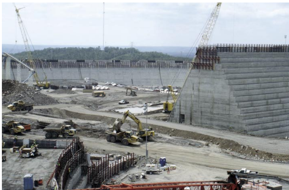
Slika 8 • Pregrada Taum Sauk v ZDA v izgradnji leta 2008. V sredini so vidni okrog 15 m dolgi deli tesnilnega betona z 1 m širokimi presledki, ki so omogočili raztezanje betona zaradi toplote pri vezanju betona. Presledke so kasneje zalili s tesnilnim betonom ob pomoči žerjava z zelo dolgo roko. Vir: http://www.stlsi.com
