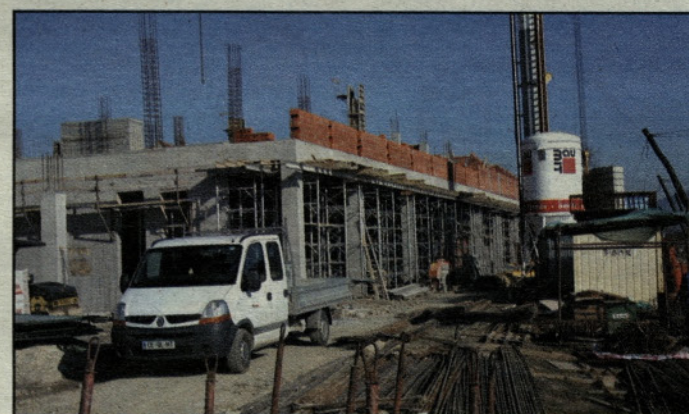
Kljub zamenjavi gradbinca na poslovno-stanovanjskem objektu v Braslovčah dela potekajo nemoteno
