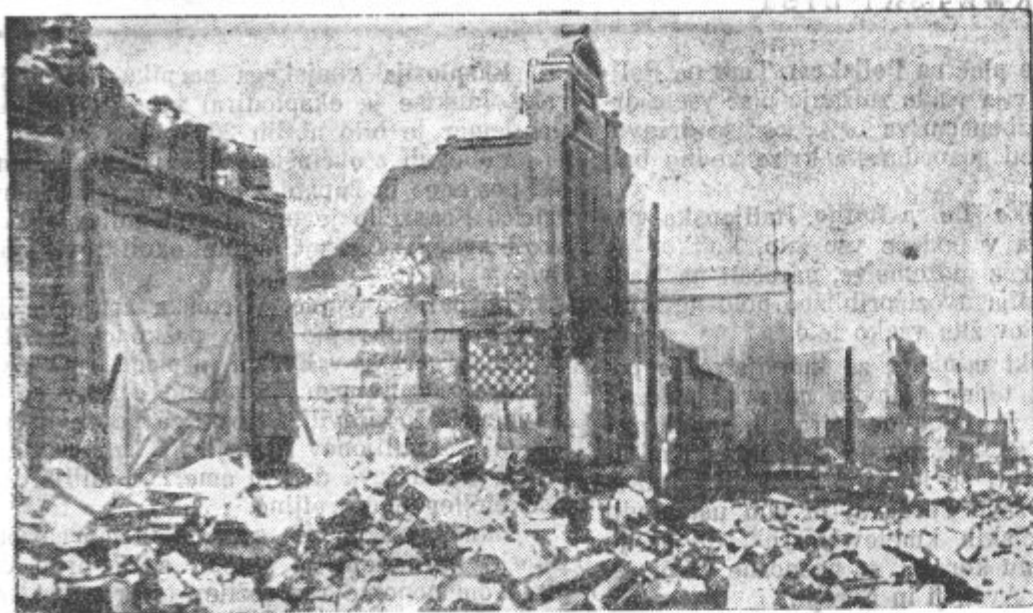
Potres na Novi Zelandiji. — Na sliki vidimo popolnoma razdejano cesto v mestu Napier na Novi Zelandiji.
