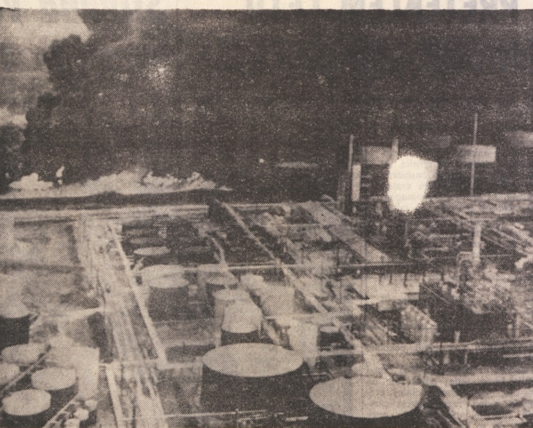
Ognjeni zublji in plameni se visoko dvigajo iz naftnih rezervorjev «tank farm» pri Port Nechesu. Požar je uničil šest hranilnikov preden je gasilcem uspelo zajeziti ognjeno reko
