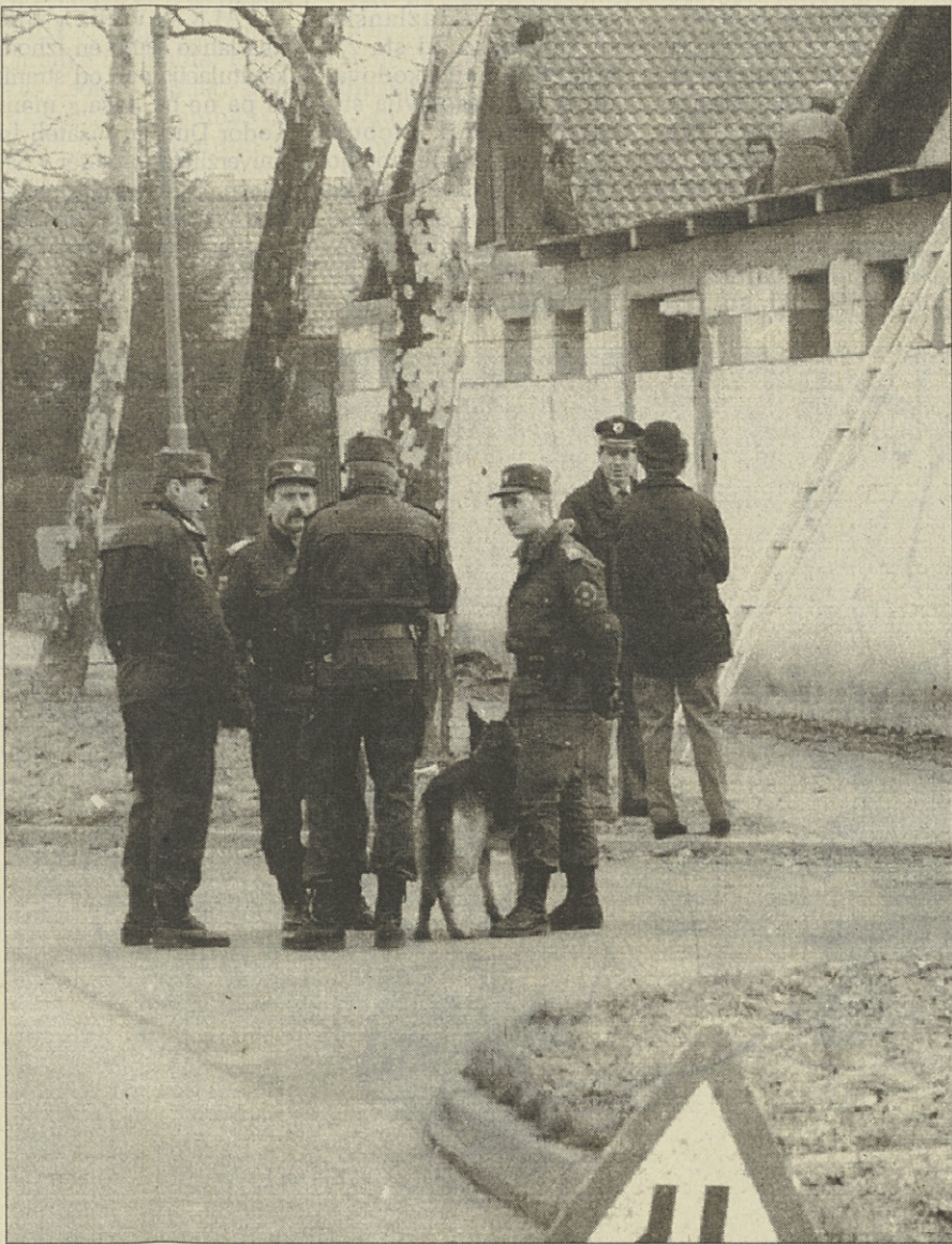
Včeraj so začeli rušiti na črno zgrajen prizidek v Šiški (Foto:Aleš Pavletič)
