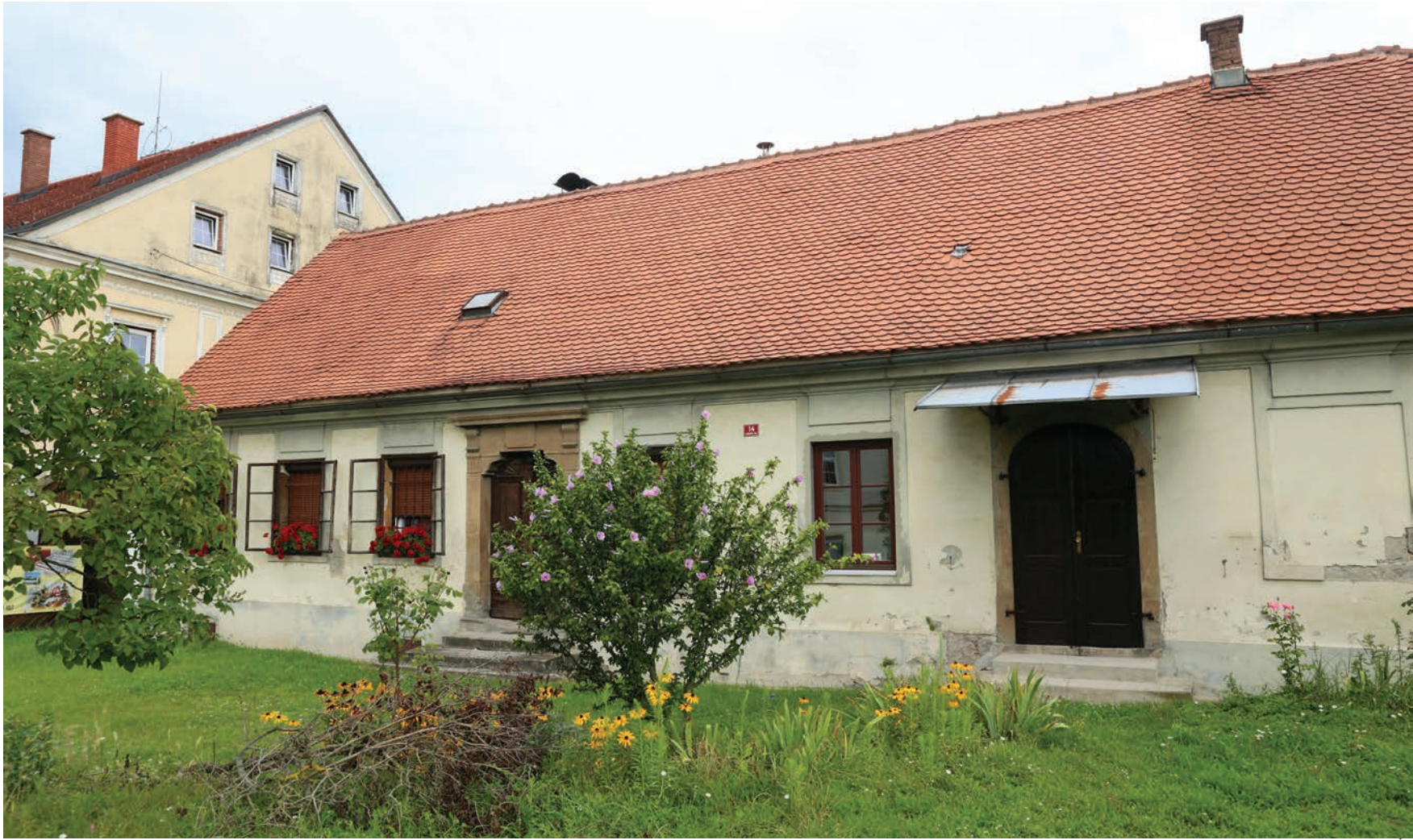
V tej stavbi bo urejen prvi ptujski center za brezdomce Kamra.
