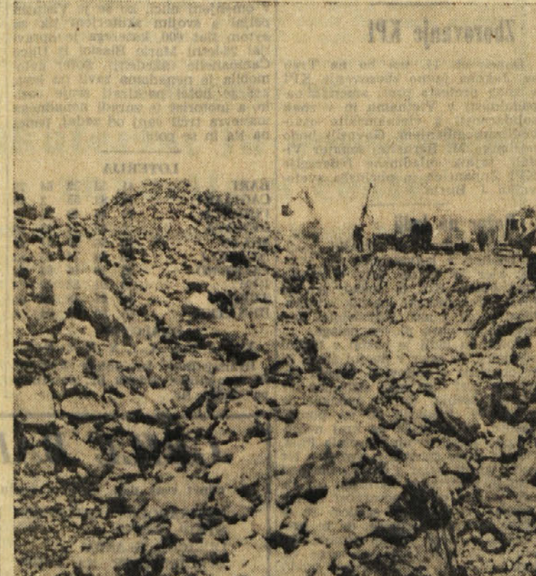
Med Opčinami in Fernetičji se kopljejo jarek za postavitve cevi natovoda
