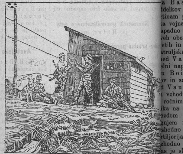
Eine Telefonzentrale in 3500m Höhe.
