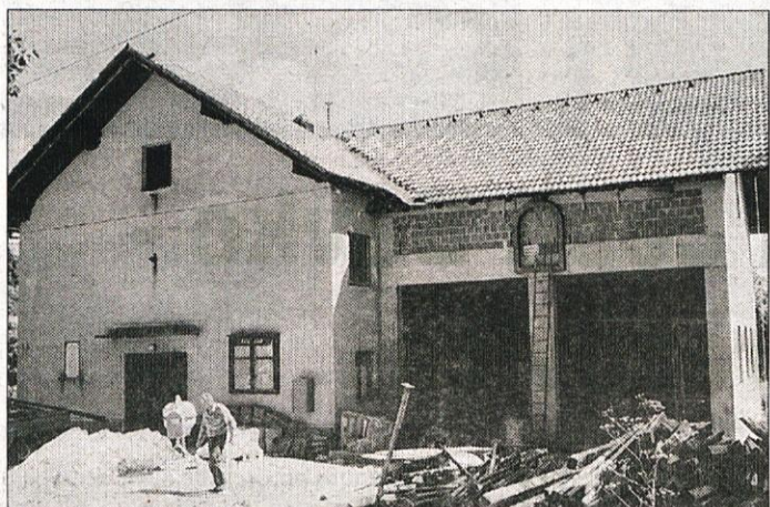
Kulturni dom v Bevkah že kaže svojo pravo podobo, na prizidku je že streha in dela hitro napredujejo.
