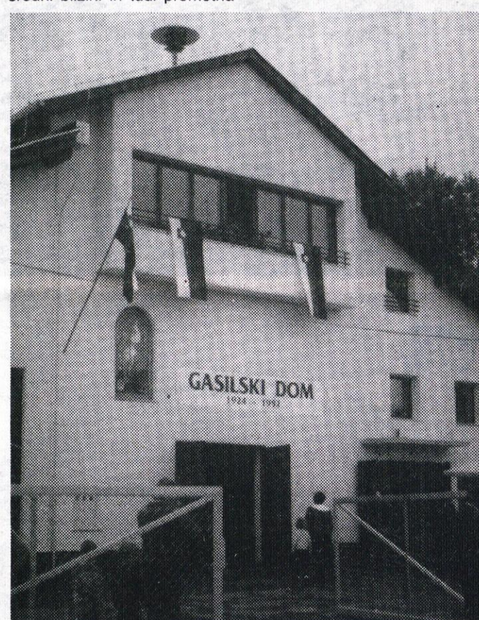
Obnovljen in na novo zgrajen gasilski dom, ki v zgornjih prostorih skriva nov učni hram Drenovega Griča.
