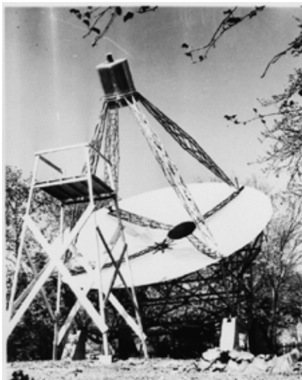
Slika 1: Parabolični reflektor s premerom 9,5 m, ki ga je leta 1937 zgradil Grote Reber v Wheatonu, Illinois, ZDA.
