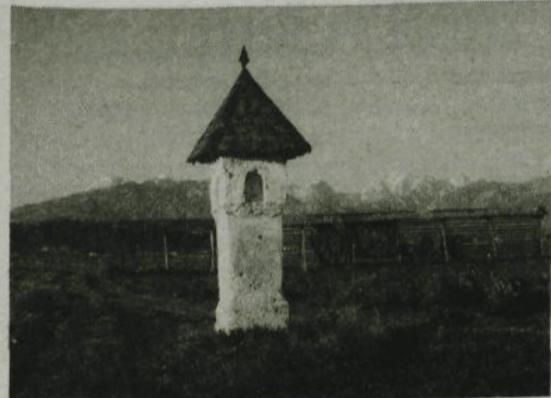
Kužno znamenje v Depali vas še čaka na obnovo
