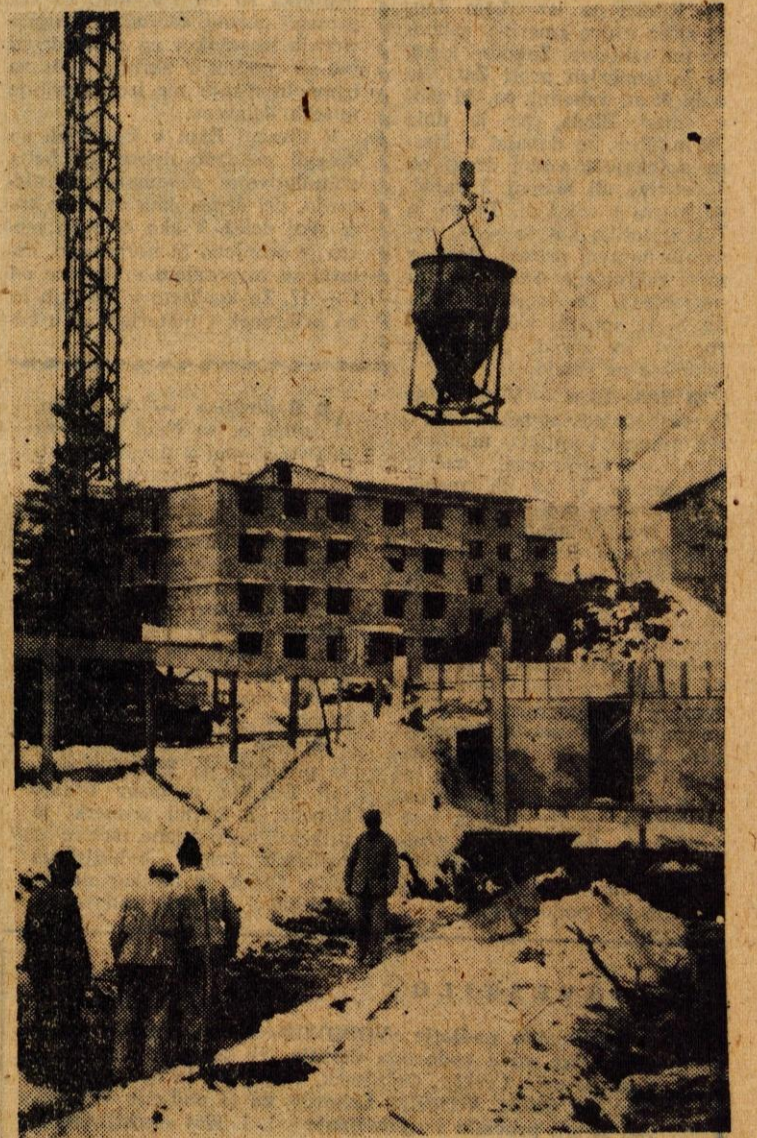
Tudi za sodnijsko poslopje v Kranju so za temelje predvideli tako imenovane vodnjake, kakršne so prvič uporabili pri gradnji stolpnice v Trzinu. Skopali in napolnili z betonom bodo 38 vodnjakov, ki bodo globoki okoli 10 metrov, do trdne podlage. Za tako delo je priimeren zimski čas.
