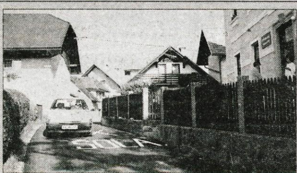
Kobarid, 27. maja - Pred dnevi so preplastili z novim asfaltom ulico, ki vodi iz središča vasi Kobarid mimo šole proti tržiškemu naselju Loka. Tam so rekonstruirali tudi križišče s cesto v servisno cono in k bodoči čistilni napravi. Dokončna cena za ureditev okrog 600 metrov dolge ceste še ni znana, plačilo pa bo občina Trzin zagotovila iz letošnjih proračunskih sredstev za obnovo lokalnih cest. • S. Saje
