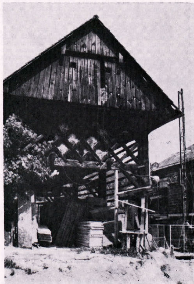
Lep lesen kozolec daje na gradbiščučasno streho za skladiščenje gradbenega materiala
