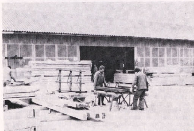
Zaradi premajhne tesarske delavnice se morajo nekatera dela opravljati kar na prostem
