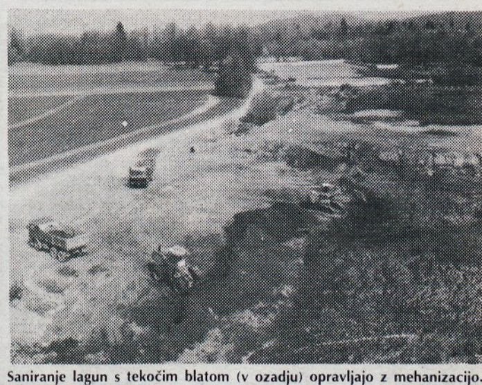
Saniranje lagun s tekočim blatom (v ozadju) opravljajo z mehanizacijo. Mešanje blata s pepeli in slabšo zemljo. V ozadju je tudi vidna nova asfaltna deponija.
