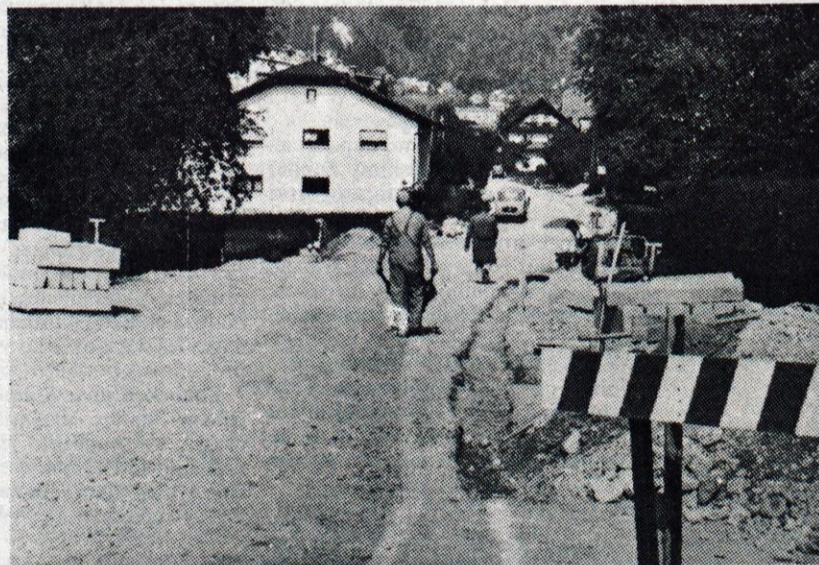
Pristava pri Tržiču, 10. oktobra - Dela pri posodabljanju ceste med naseljem Pristava in Križe, ki so jih zaradi pomanjkanja denarja poleti prekinili, se nadaljujejo po sprejetju proračuna občine Tržič. V njem so namreč namenili za dokončanje te ceste 16 milijonov tolarjev. Delavci SGP Tržič sedaj polagajo robnike na odseku proti odcepu za naselje Podvasca, še ta mesec pa naj bi bila cesta v celoti pripravljena za polaganje asfalta. Tega si najbolj želijo domačini in tisti prebivalci, ki se iz kriške smeri vozijo na delo v Tržič. • S. Saje
