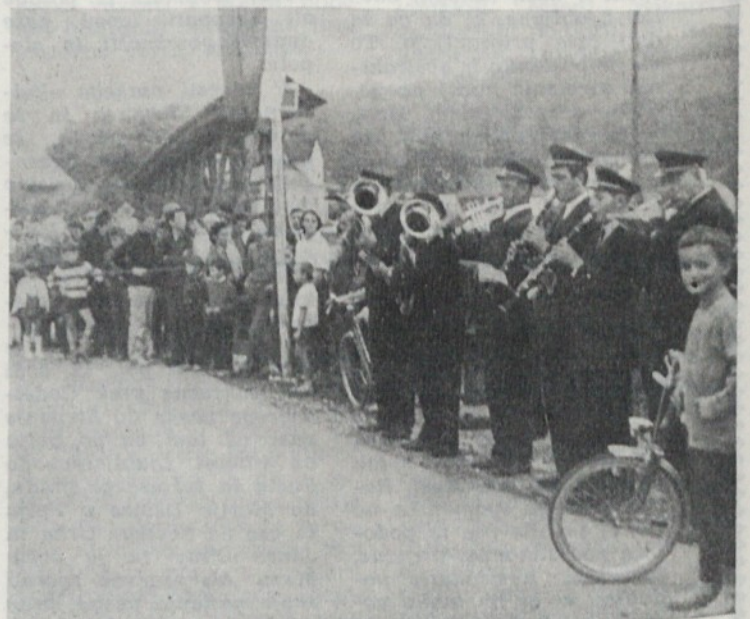
Vevška pihalna godba ob otvoritvi rekonstruiranega cestišča v Štepanji vasi
