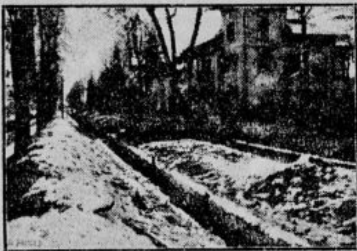
Kanalizacija v Koroševi ulici.
