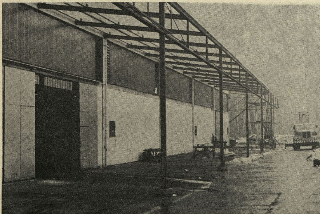
Gradnja nadstreška za surovine pri novi livarni
