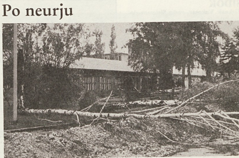
Neurje z viharjem, ki je 23. avgusta letos divjalo nad vso Slovenijo, najhujše pa čez Logatec in Vrhniko, tudi Litostroju ni prizaneslo. Na stavbi TVN je odprlo celo steno iz profiliranega aluminija z vgrajeno toplotno izolacijo v velikosti 5,5 x 10 m.
