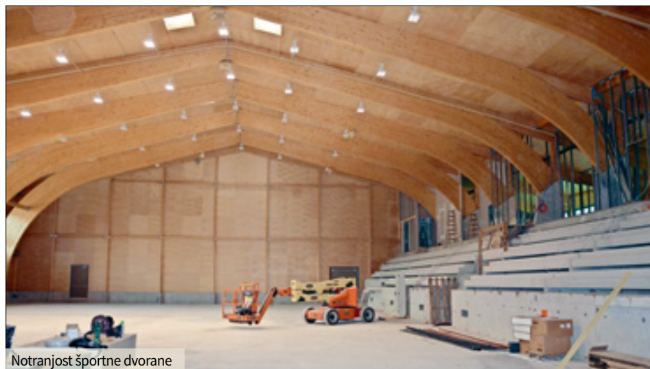
Notranjost športne dvorane
