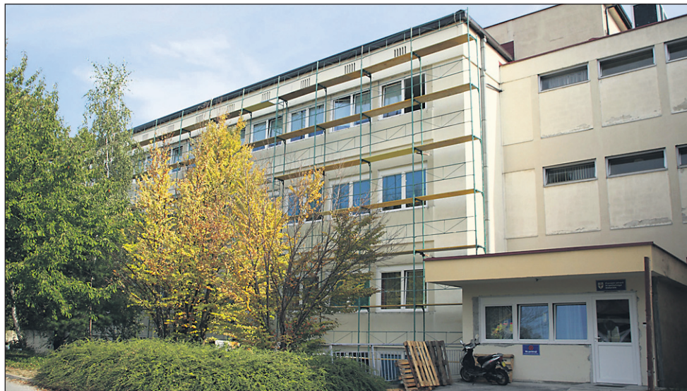
Energetska sanacija ptujske bolnišnice poteka po načrtih.
