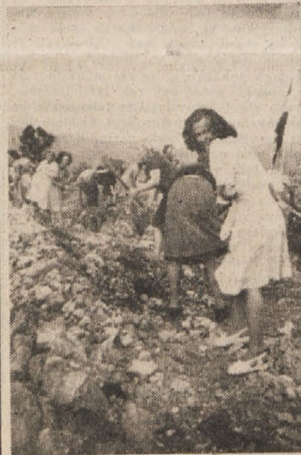
Sindikalne podružnice delajo pri vodovodu na cesti Markovščina-Slivje v idrijskem okraju
