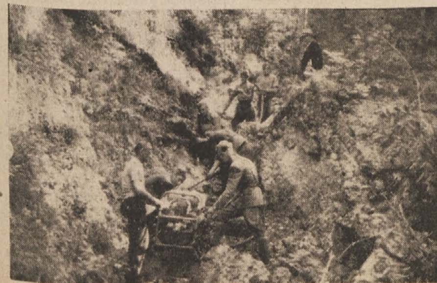
Minerji pri kopanju temeljev za novi vodovod v Stajah pri Idriji
