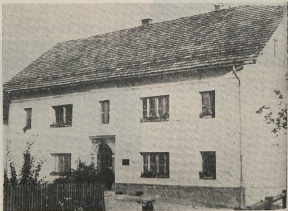
Slika dovolj zgovorno priča o tem, kako je potrebno novo šolsko poslopje. Stavba je že stara več kot sto let in zato že zdavnaj ne ustreza današnjemu šolskemu življenju. Pouk poteka v treh izmenah in grozi že četrta.
