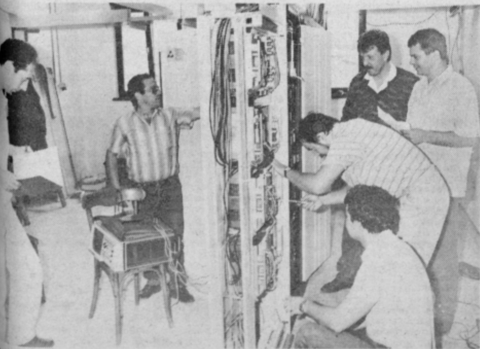
Montaža nove telefonske centrale
