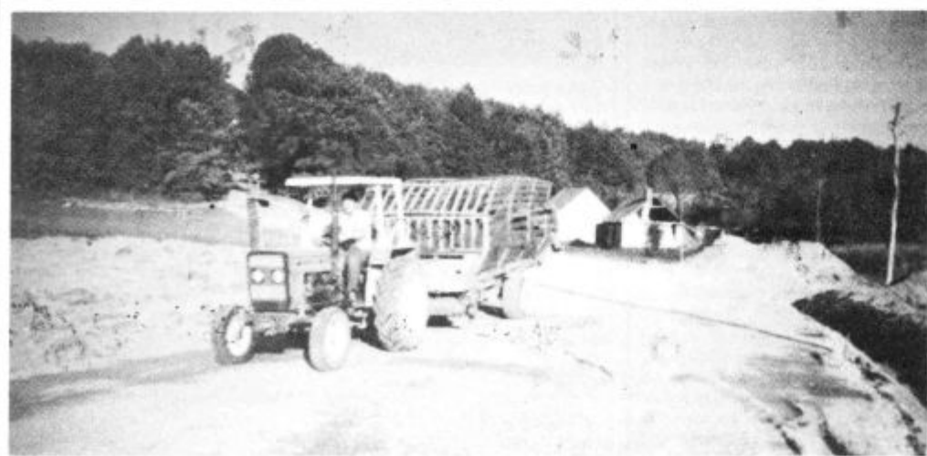
Preostanek makadamske ceste v Spodnji Senarski bo dobil asfaltno preobleko
