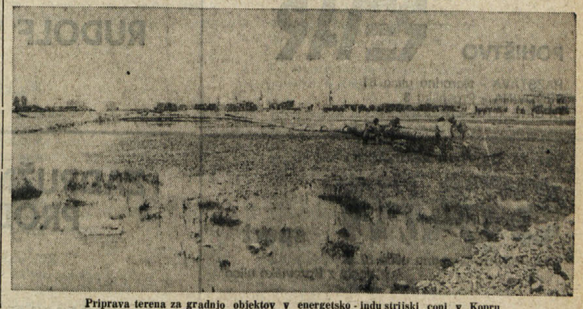
Priprava terena za gradnjo objektov v energetsko-industrijski coni v Kopru
