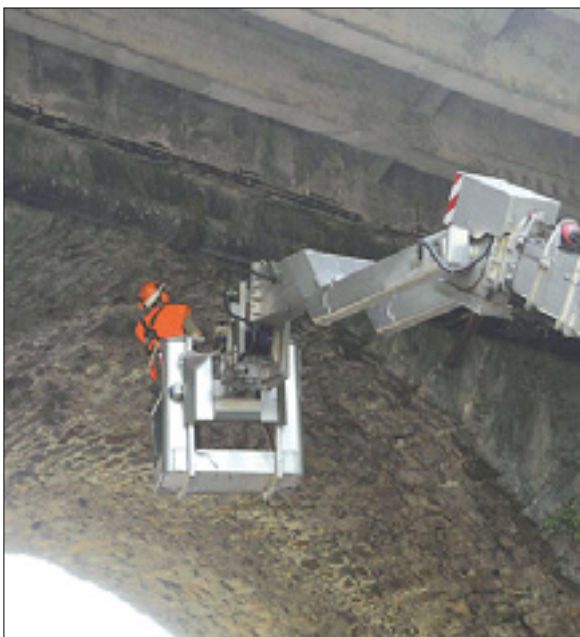
Občinski delavci pregledujejo obok mosta
