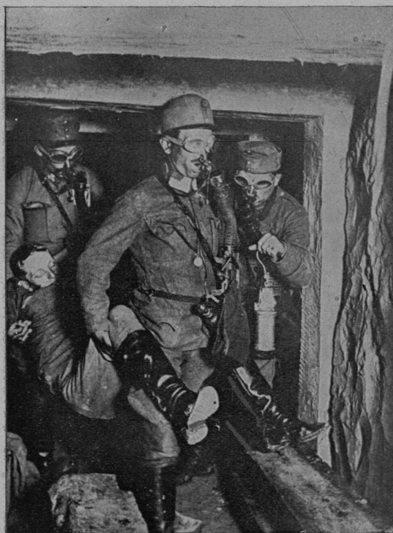
S tirolske fronte: Naši vojaki odnašajo iz rova na zrak tovariša, ki so ga omamili jamski plini. Moštvo je opremljeno z maskami in s kisikovimi aparati proti strupenim plinom.
