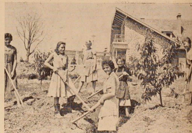
Na sliki: zaključna dela pri gradnji vodovoda.
