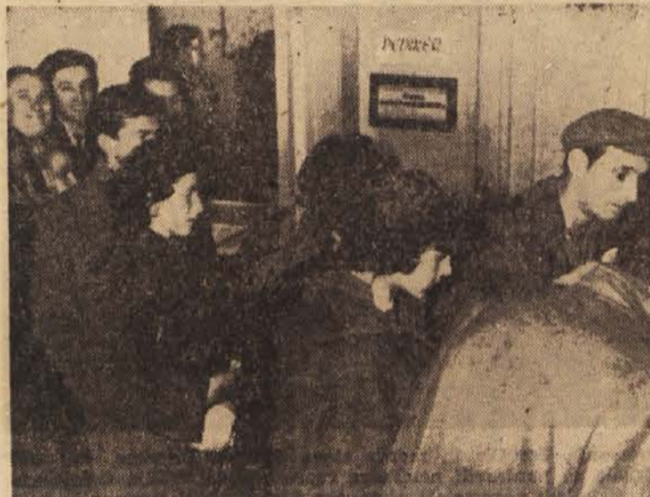
Kopalnice »Slon« bodo, kot kaže, v bližnji bodočnosti podrti. Tedaj naj bi razširili javno kopalnico na Miklošičevi cesti. Toda kadi in prh bo tudi v takem primeru premalo in še bo treba stati v »repih« pred kopalniško blagajno
