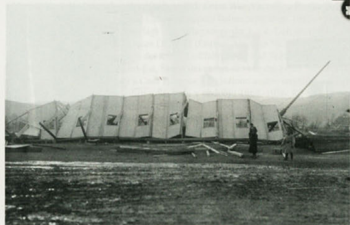
Zaradi burje porušen delno zgrajen Lordov leseni hangar na letališču Vipava–Podraga januarja 1917 (ÖStA/KA, Baugruppe LFT Kart.319 zu Res.Nr.5-1 Bild5 – pridobil Matjaž Ravbar)
