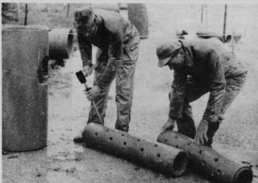
S področja kanalizacije so moštva izdelovala vtočni jasek in priključni drenažni cevi. Na sliki sta celjska tekmovalca, ki sta zasedla peto mesto.
