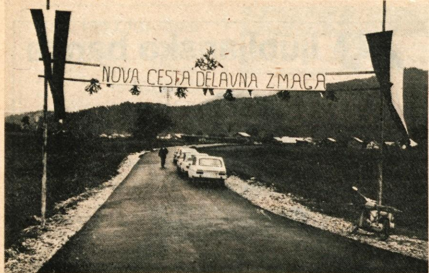
V nedeljo, 13. oktobra, so na Senici predali namenu nov 2400 metrov dolg asfaltiran odsek ceste od tovarne celuloze do odcepa na cesto Jeperca—Škofja Loka, ki je za Zg. in Sp. Senico ter Ladjo velika pridobitev. — Foto: fr
