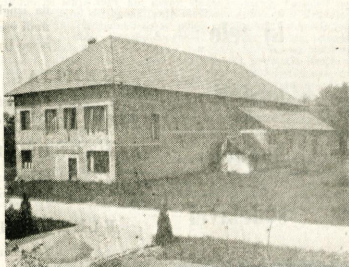
Ze mnogo let stoji na Hromcu nedograjen Zadrudni dom. Z ob časa je že precej načel to, še nedokončano gradnjo, krajevne množične in politične organizacije pa so brez lastnih prostorov. Ali ni škoda, da to poslopje propada? Ali res ni nikdar, ki bi ga znal koristno uporabiti?
