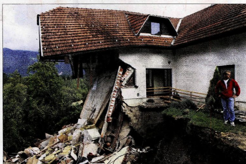
Uničeno hišo na Trnovcu so v sredo ob pomoči Nivoja in sosedov že popravljali.
